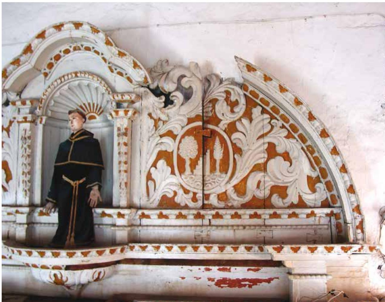
fotográfico, sin embargo fue cubierto nuevamente al ser montadas las diversas piezas que estructuran al Retablo. Todo ello previo a un cuidadoso trabajo de albañilería en el que se resolvió la inestabilidad de los materiales de mampostería para garantizar un buen anclaje del retablo al muro.
